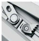
**6.** Ein Mechanismus mit 5-stufiger Kippweiten-einstellung reguliert ganz einfach die Intensität der Lüftung und kann für jeden Raum passend eingestellt werden.
